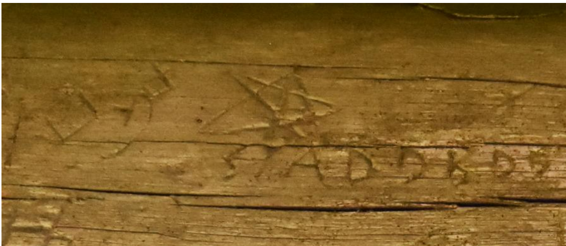
Nr 4 - MJÖLKBODEN, höger om dörren på utsidan
